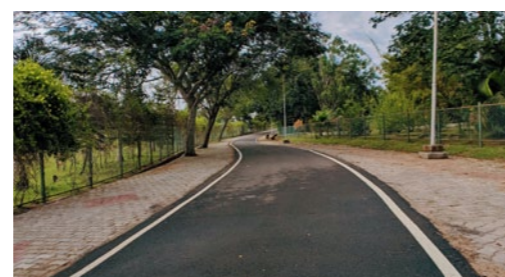
Verkehrsfläche mit Asphaltbelag
