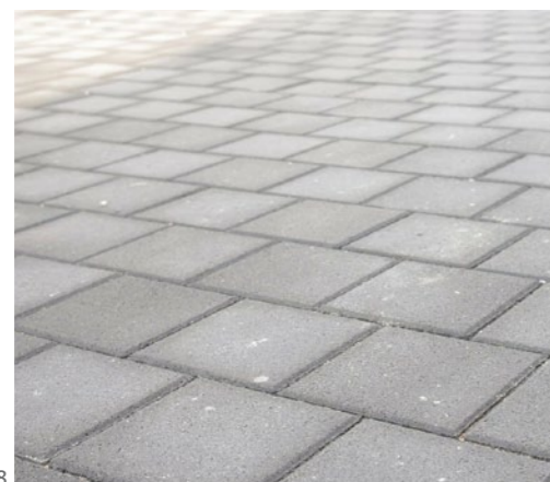
Plattenbelag aus Betonwerkstein
